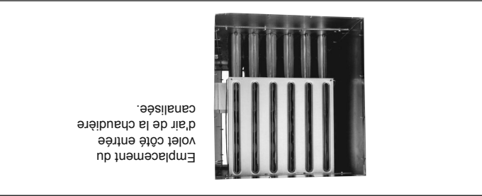
Figure 4.1 – Emplacement du volet de distribution d'air
